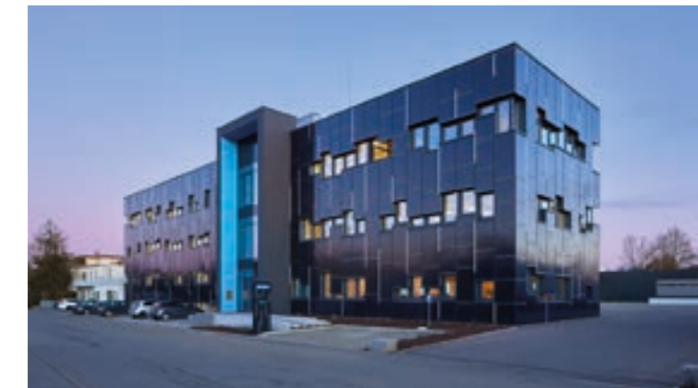
Die Fassade von Mader besteht aus 397 Photovoltaik-Modulen.
